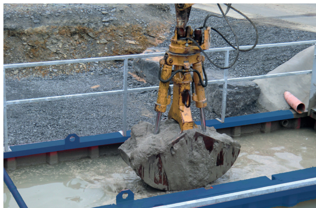
Manueller Schmutzaustrag durch Bagger Manual dirt removal with excavator
