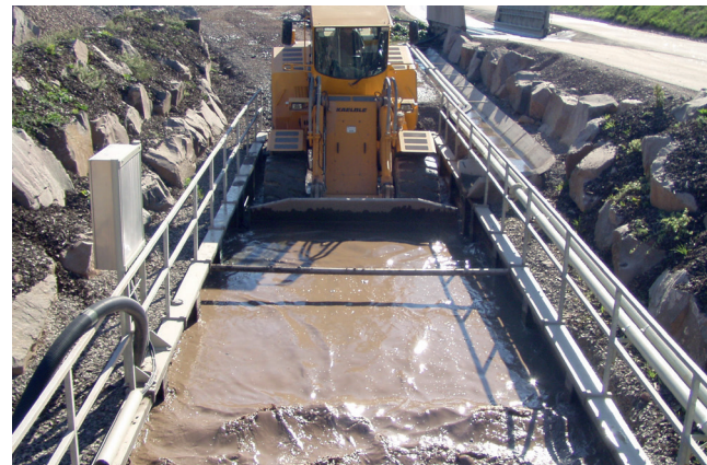
Manueller Schmutzaustrag durch Radlader Manual dirt removal with wheel loader
